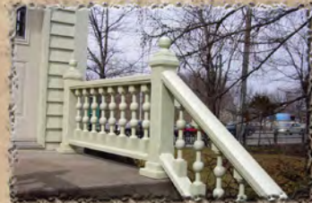
Garde-corps en bois
