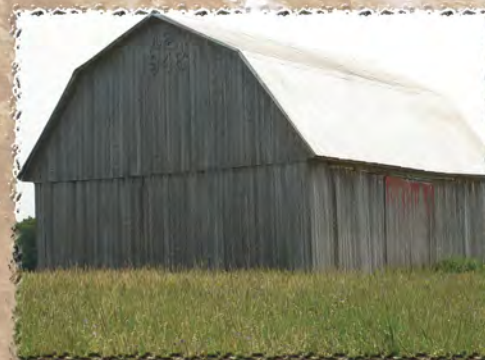
Grange située à Sainte-Ursule recouverte d'un toit à versants dit "brisés". Ce type de bâtiment est fréquent dans la MRC.
