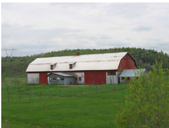
Grange-étable au toit à versants brisés, chemin de la Grande-Ligne à Saint-Paulin. IMG_6927.jpg
