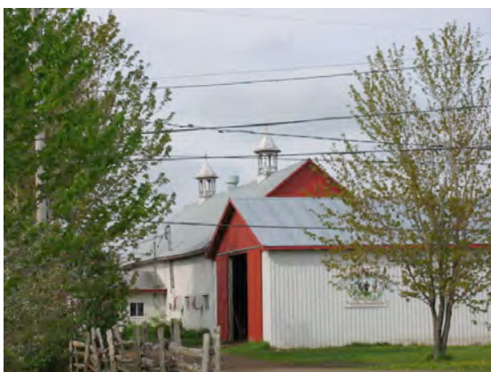
Grange-étable en bordure de la route 348 à Sainte-Ursule. Elle est dotée de lanternons de ventilation. IMG_6875.jpg
