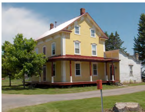
Sur cette maison du rang de la Rivière-Sud-Est de Maskinongé, on a conservé les chambranles malgré la mise en place de fenêtres à guillotine modernes. HPIM0466.jpg
