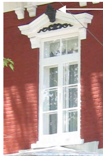
Au 581, rue Sainte-Anne, à Yamachiche, les fenêtres dont les corniches sont surmontées d'un écusson en fonte demeurent très rares au Québec. Elles sont représentatives de la MRC de Maskinongé. IMG_7072.pg
