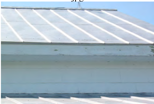
Chemin de la Rivière-du-Loup, Yamachiche. Exemple de revêtement de tôle pincée, très fréquente sur les toitures. 1160rdl-f.jpg
