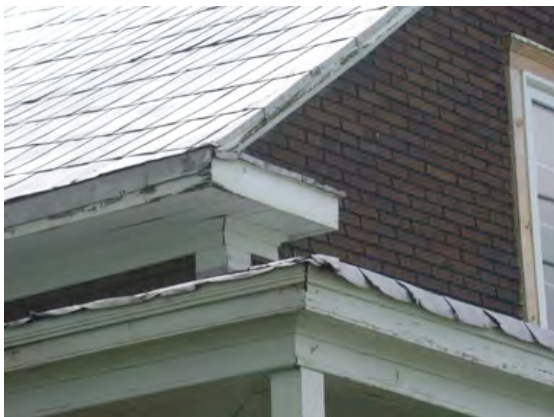
Saint-Sévère. Exemple de retour de corniche Maison Frédéric Gélinas (6).jpg
