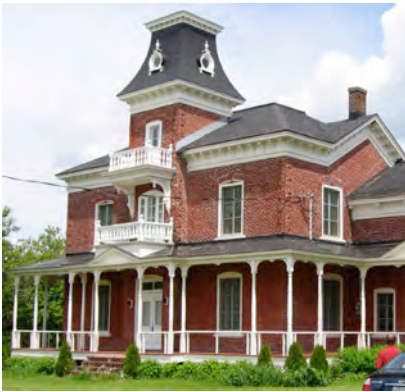
Au 580, rang Lamy, Saint-Léon-le-Grand. Cette maison victorienne est singularisée par la tourelle à toit de forme pavillonnaire. IMG_7092.jpg
