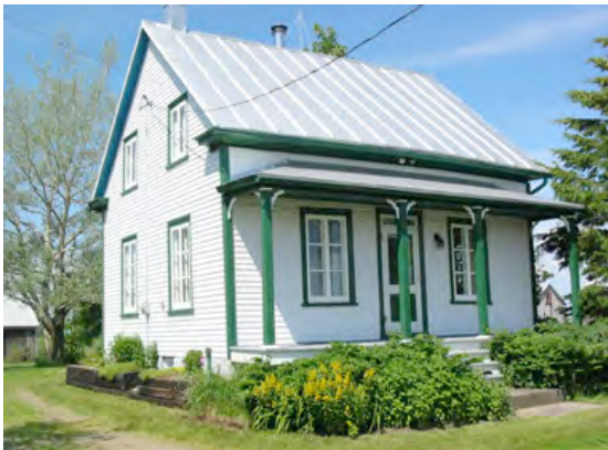
Chemin de la Rivière-du-Loup, Yamachiche. Exemple de revêtement de clin de bois. 1151rdl-c.jpg
