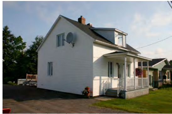
Immeuble de Saint-Mathieu-du-Parc dont la fenestration a été passablement modifiée. IMG_316.JPG
