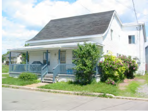
Maison d'esprit québécois d'Yamachiche dont la volumétrie n'est plus conforme à celle d'origine : les deux versants du toit sont asymétriques et le versant arrière a été rehaussé. 220nb-b.jpg
