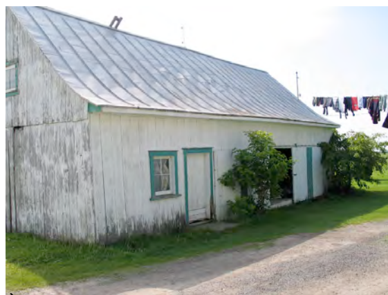
À Saint-Léon-le-Grand, une grange-étable à toit à deux versants à coyaux. À gauche, la porte d'étable; à droite, la porte coulissante de la batterie. IMG_3525
