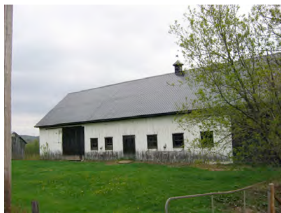
Une grange-étable, route 349 à Saint-Alexis des-Monts. Elle est revêtue de planches verticales et a conservé ses ouvertures anciennes. IMG_6894.jpg
