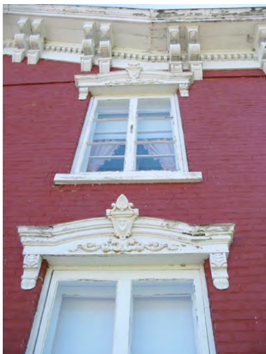
Yamachiche. Consoles et corniches très ouvragées de fenêtres dotées notamment de consoles aux extrémités et d'appliques. 150gela-kf.jpg
