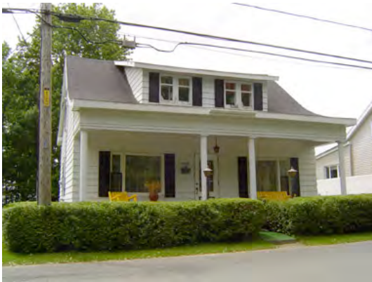
Maison d'esprit québécois de Louiseville dont la format des fenêtres a été transformé. DSC01868.jpg
