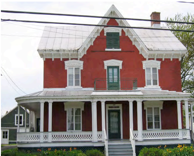
Corniche avec consoles ouvragées d'influence Bracketted Style. Maison Rivard-Desaulniers, 581, rue Sainte-Anne, Yamachiche. IMG_7072.jpg
