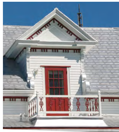
Au 890, rang Barthélémy, Saint-Léon-le-Grand, une lucarne-balcon surmontée d'un haut fronton. Le garniture du garde-corps est en fonte moulée. IMG_3662.jpg
