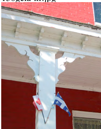
Yamachiche. Aisseliers, situés au sommet d'une colonne supportant un auvent. 170gela-k.jpg
