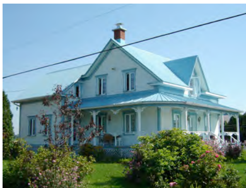
Rang Philibert, Sainte-Ursule. Les fenêtres d'origine ont été remplacées mais pas les chambranles. DSC01409.jpg
