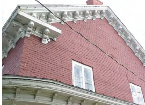
Yamachiche. Un retour de corniche (à gauche) et un avant-toit décorés de consoles particulièrement ouvragées. 800bd-f.jpg
