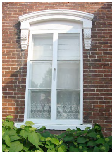
Yamachiche. Corniche à arc surbaissé avec, aux extrémités, des consoles ouvragées. 711sta-k.jpg
