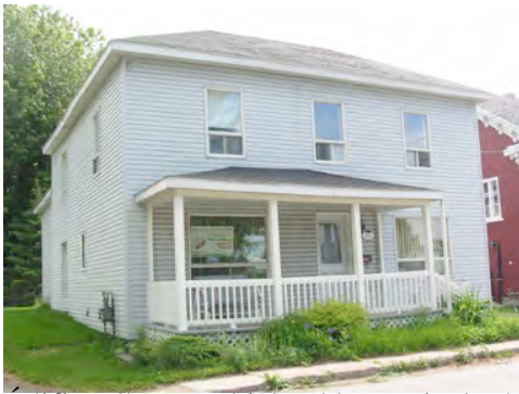
Édifice d'Yamachiche désormais doté de fenêtres modernes aux dimensions non uniformes. Enfin, les garnitures de rive sont disparus. 810bd-c.jpg
