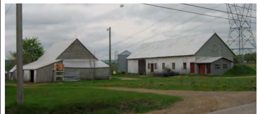
Route du Ruisseau-Plat, Saint-Édouard-de-Maskinongé
