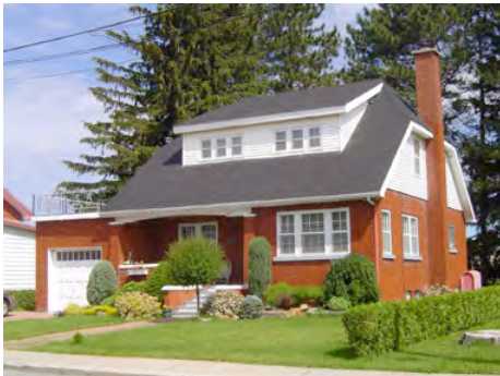
Bungalow ancien de Louiseville. En plus des caractéristiques ci-haut mentionnées, on remarque le revêtement et la cheminée de brique, tous deux d'origine. DSC01640.JPG
