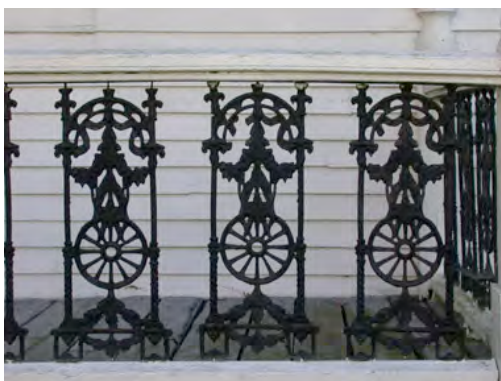
Saint-Barnabé. Garde-corps en fonte moulée. Ce type de garde-corps plutôt rare au Québec est présent chez quelques édifices dans la MRC de Maskinongé. Saint-Barnabé Maison B (12).jpg
