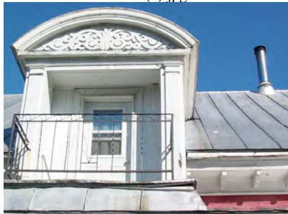
Yamachiche. Lucarne de forme demi-cylindrique avec une applique au fronton. 170gela-d.jpg
