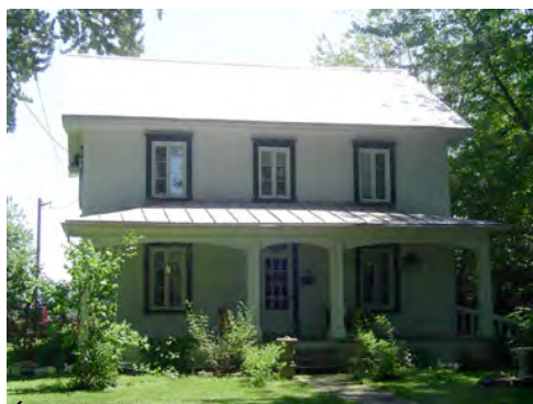
Édifice de l'avenue Royale à Louiseville où l'on a conservé les chambranles malgré la mise en place de nouvelles fenêtres. Le modèle de ces dernières (à manivelle et imitant les fenêtres à battants à grands carreaux) sont en outre fort acceptables. DSC01450.jpg
