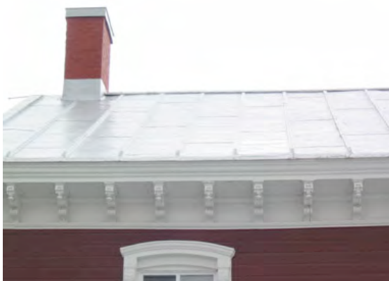
Yamachiche. Corniche à consoles en bordure du toit. 670sta-k.jpg
