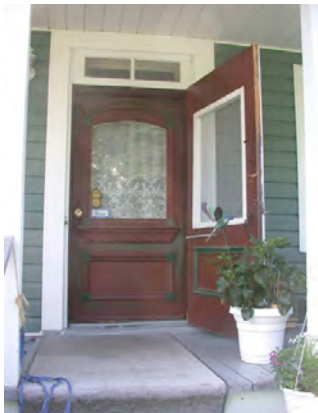
Saint-Sévère. Porte ouvragée surmontée d'une imposte. Maison Lise Héroux (4) jpg
