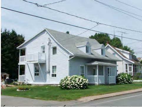
Édifice de Saint-Étienne-des-Grès dont la volumétrie a été modifiée : le versant arrière de la toiture a été rehaussé. DSCF2655.jpg
