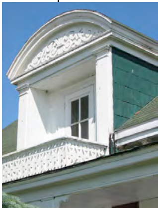
Yamachiche. Lucarne de forme demi-cylindrique avec une applique au fronton. 141pt-f.jpg
