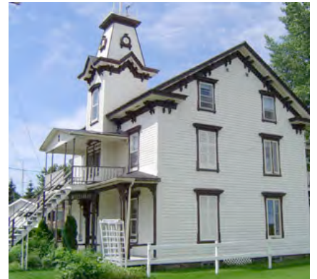
Le 581, Notre-Dame Nord, Louiseville. Exception faite du revêtement, ce bâtiment présente des caractéristiques comparables à celles du 150, Gérin-Lajoie, particulièrement la tourelle qui est pratiquement identique. DSC01702.jpg
