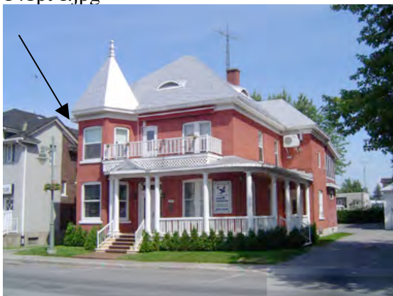
Avenue Saint-Laurent, Louiseville. Un oriel (fenêtre en saillie sur deux niveaux) surmonté d'un toit de forme polygonal. DSC02122.jpg
