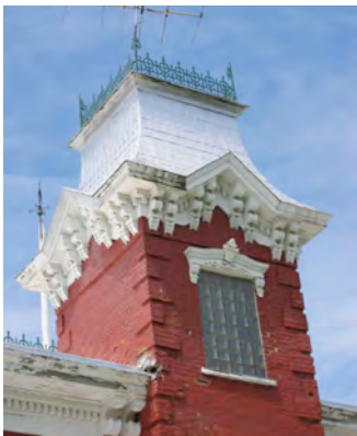
Au 150, rue Gérin-Lajoie à Yamachiche. Détail de la tourelle avec toit en pavillon surmontée d'une petite terrasse faîtière IMG_7084.jpg
