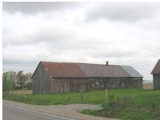
Grange-étable dont l'implantation suit l'orientation des lots cadastraux sur la route du Ruisseau-Plat à Saint-Édouard-de-Maskinongé. IMG_6883.jpg
