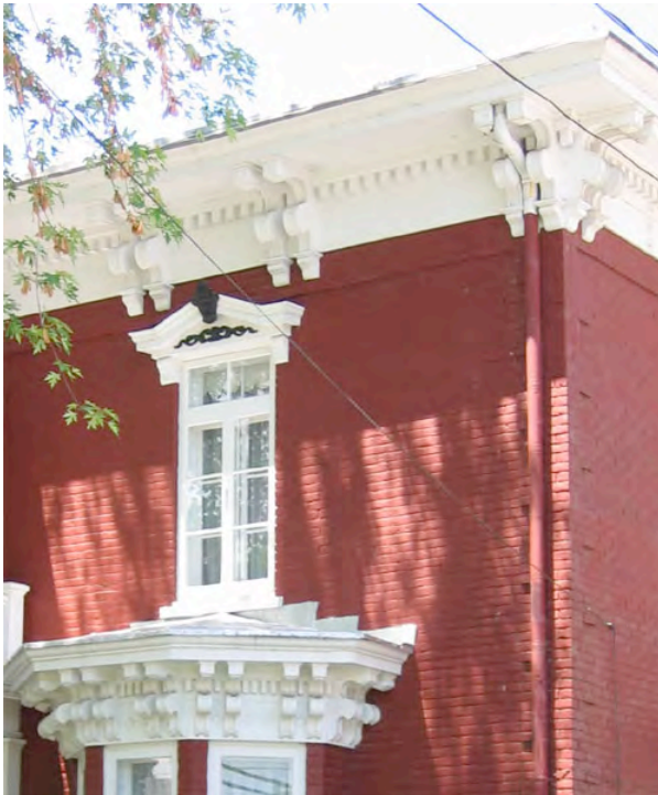
Corniche avec consoles ouvragées d'influence Bracketted Style. Maison Rivard-Desaulniers, 581, rue Sainte-Anne, Yamachiche. IMG_7072.jpg
